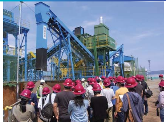
宮古地区破碎選別プラント
